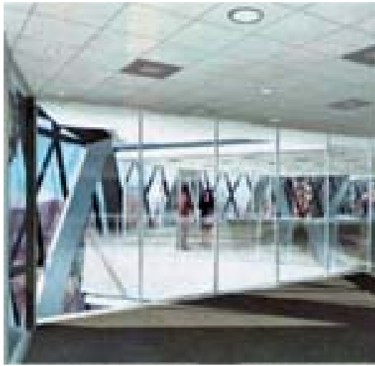
Фрагмент вестибюля башни «Swiss Re». На снимке хорошо виден диагонально-сетчатый каркас из стальных труб.
