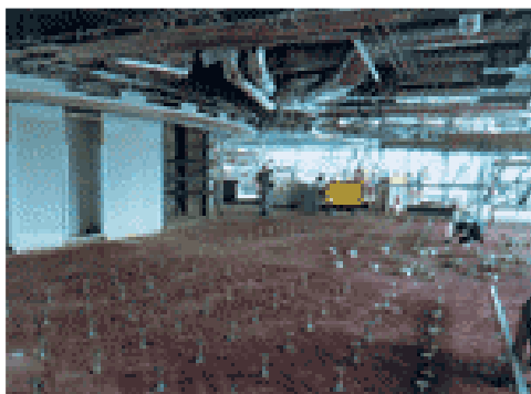
Этап надстройки полов на этаже. На уровне потолка видны один из вентиляционных конвекторов и фрагмент сети воздуховодов.
