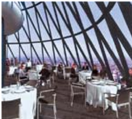
Фрагмент ресторана, расположенного на последнем этаже здания «Swiss Re». Хорошо видна диагонально-сетчатая структура из стальных труб. Это единственное место, для которого потребовалось гнутое стекло, образующее стеклянный купол башни.
