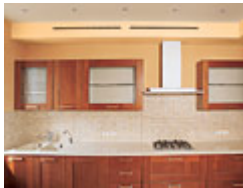
Для подачи свежего и удаления загрязненного воздуха на кухне использованы эффективные линейные воздухо-распределители
