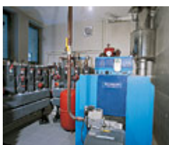
Модули быстрого монтажа MEIBES упрощают монтаж котельной
