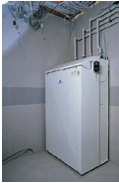
Водоохлаждающая машина Gold Cooler компактна. Она занимает менее 1 м 2 площади венткамеры
