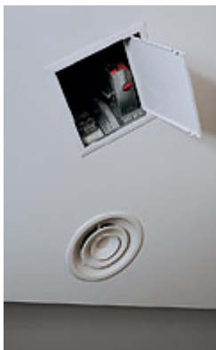
Сервисный люк для доступа к ирисовому клапану, стоящему в устье подводящего воздуховода перед диффузором
