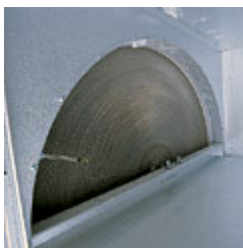
Роторный теплоутилизатор Gold представляет собой короткий
