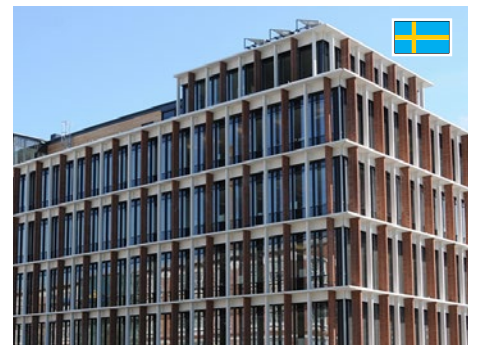
Bengt Dahlgren Head Office, Гётеборг
